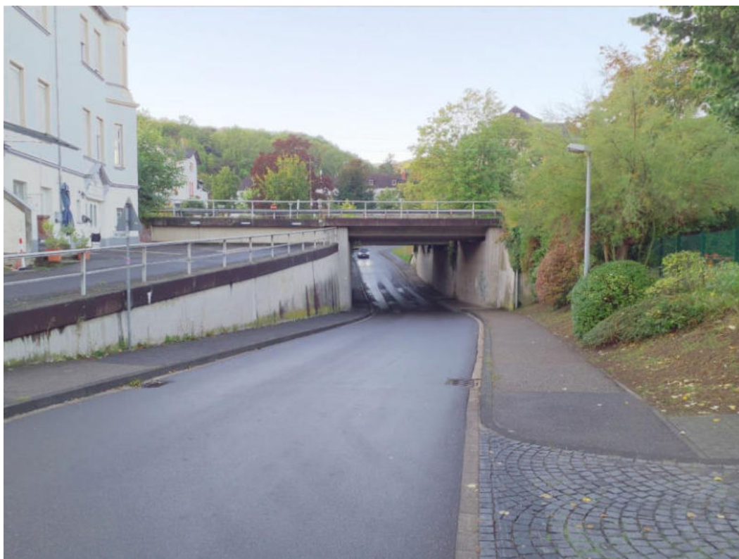
Abbildung 3 Unterführung aus der Blickrichtung Boppard-Rheinufer
