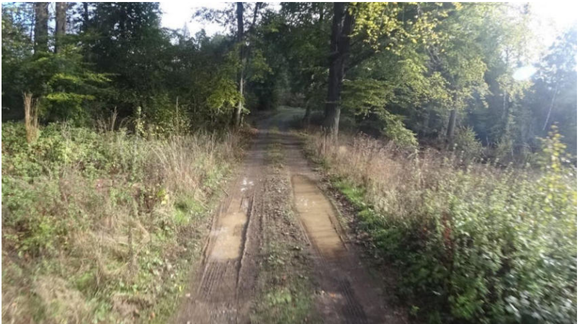
Abbildung 7: Pfützenbildung an einer ansteigenden Stelle.
