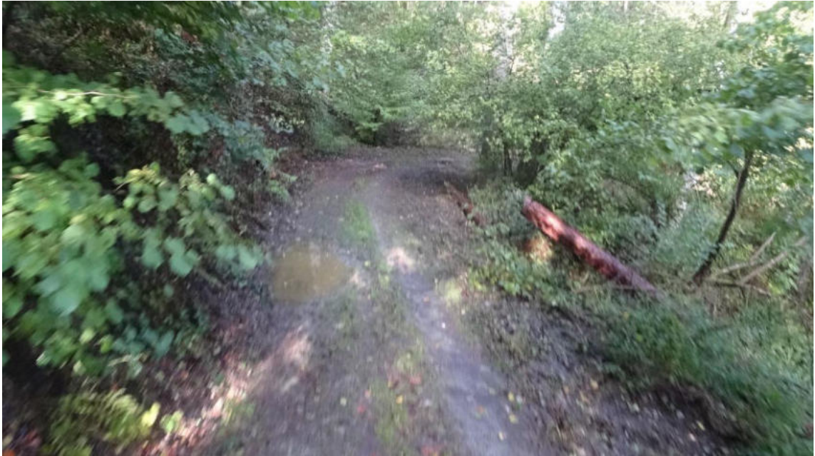
Abbildung 8: Pfützenbildung in einer Kurve.
