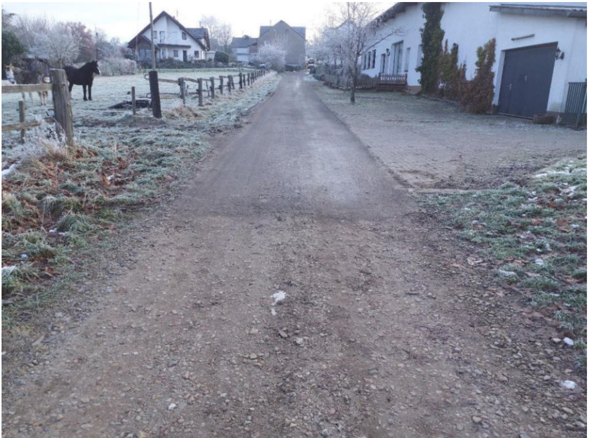
Abbildung 3: Deckschicht Wechsel Hubertusstraße und Flurweg
