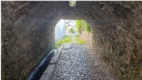
Unterführung B9 Burdenbach
