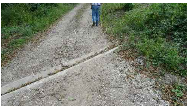
Gering dimensionierte Wasserabschläge im Hohlweg – Schaffung größerer Abscheide in die Waldflächen (z.B. durch Rigolen)
