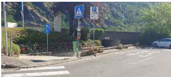
Aufgrund der Dammlage der B9 ist die Fußgängerunterführung ein wichtiger Abfluss bei Wasserfluss auf den Notabflusswegen – Hier kann durch den Rückbau der Rundborde und den Einbau von flächengleichen Borden der Abfluss verbessert werden.
