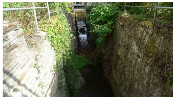
Unterführungsbauwerk bei Fondels-Mühle
