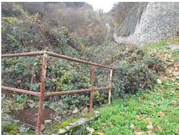
Einlaufbauwerke freischneiden und kontrollieren
