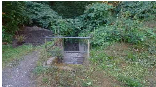
Einlaufbauwerk oberhalb der Ortslage
