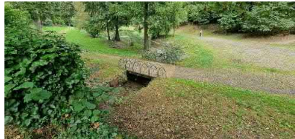
Brückenbauwerk mit Zulauf in den Teich
