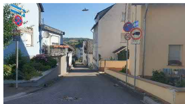
Obere Fraubachstraße: Hochborde und private Mauern schützen die Anlieger (bis zu einem bestimmten Ereignis)
