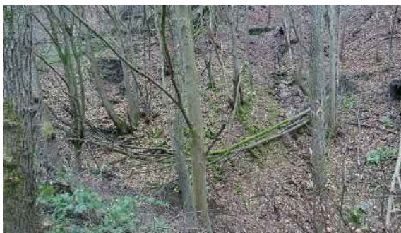
Hangabbrüche und Auswaschungen bei seitlichen Zuläufen
