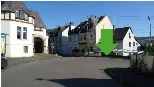
Kreuzung Buchholzer Straße / Sabelstraße: Sicherung des tiefer liegenden Gebäudes durch Hochbord bzw. Bestandsmauer
