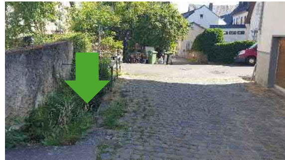
Burdengasse / Leiergasse – Pflegemaßnahmen sind regelmäßig durchzuführen
