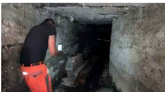
unterhalb der Bebauung
