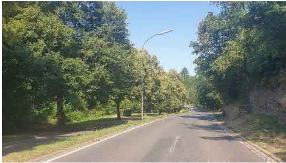
Abfluss Richtung Fußweg
