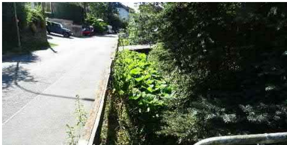
Straßenraum Mühlalstraße: Bei Übertritt verläuft das Wasser auf der Straße
