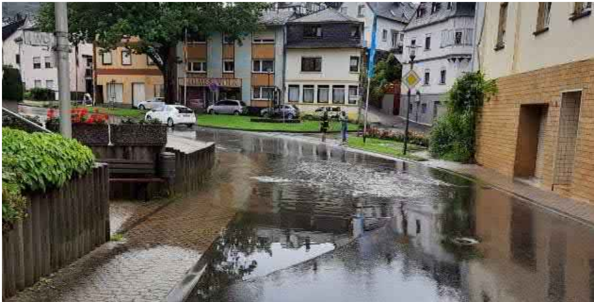
Foto 11: Tiefpunkt St. Ägidiusstraße 3 – hier sammelt sich das Wasser vor der Feuerwehr
