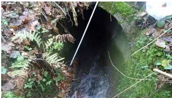
Geringe Durchlassquerschnitte
