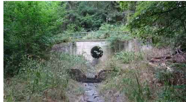
Auslaufbauwerk südlich der Autobahn
