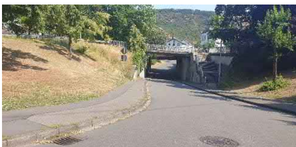
Unterführung „Am Casino“
