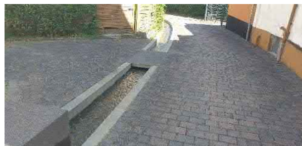
Liebensteinstraße – Bsp.: private Schutzmaßnahmen (Verschluß des Kellerfensters) ist angeraten (s.a. Kapitel 12.1)
