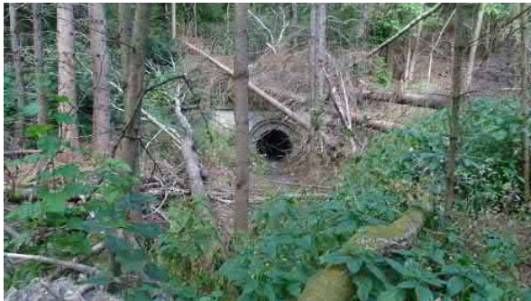
Einlaufbauwerk nördlich der BAB 61
