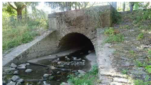
Auslaufbauwerk und Mündung in den Rhein
