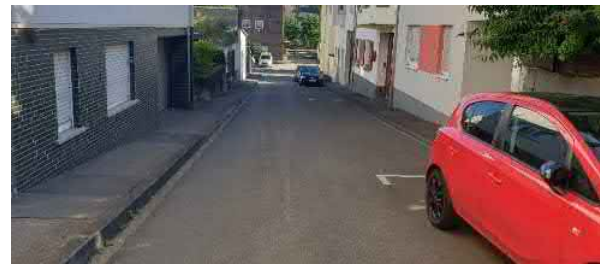
Gedeonstraße: bestehende Hochbordanlage leitet den mögl. Wasserfluß
