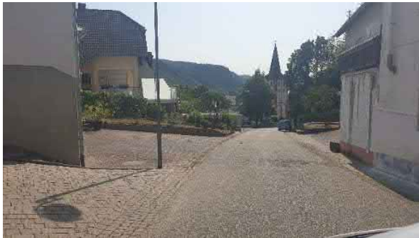
K115 / Kirchstraße Hoffflächen mit Gefälle zum Straßenraum
