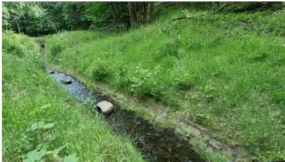
Teilw. gestickte Bachsohle nach Auslaufbauwerk im Oberlauf
