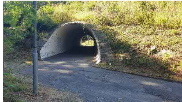
Abfluss Unterführung Marienbergpark
