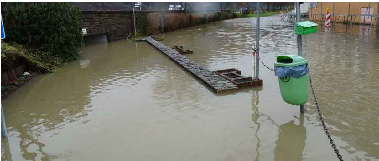
Foto 05: Überschwemmung im Bereich der Fußgängerunterführung
