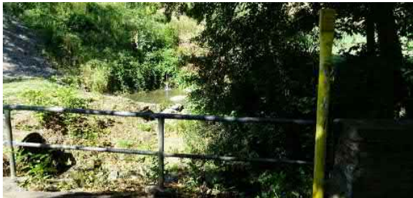
Auslaufbauwerk des Bruder-Michels-Bachs vor Marienberger Park
