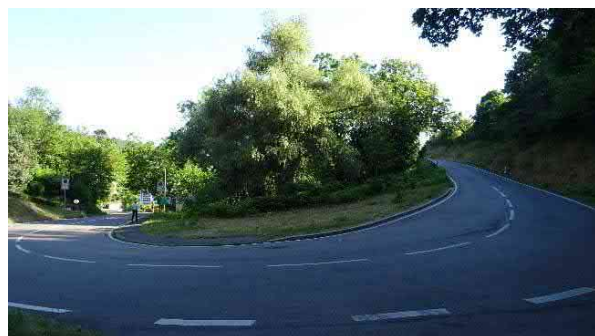
Straßeneinmündung in Buchholzer Straße: Der Notüberlauf erfolgt über den Straßenraum.
