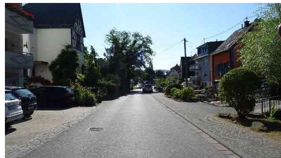
Bsp.: im Überschwemmungsfall läuft das Wasser bis an die Hauseingänge – hier sollten die privaten Anlieger weitere Maßnahmen ergreifen, da die Zufahrten einen Hochbord ausschließen (siehe Kapitel 5)
