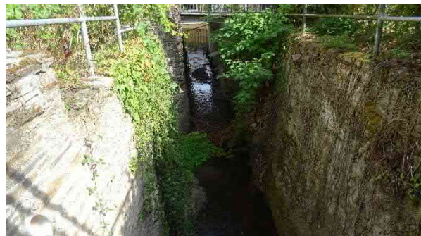
Unterführungsbauwerk bei Fondels-Mühle
