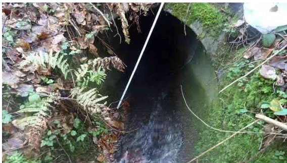
Geringe Durchlassquerschnitte
