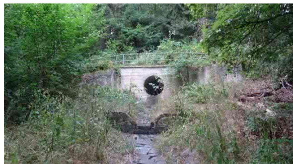
Auslaufbauwerk südlich der Autobahn
