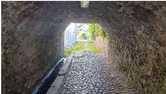
Unterführung B9 Burdenbach
