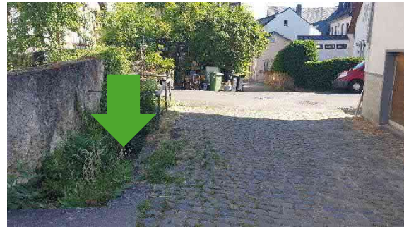
Burdengasse / Leiergasse – Pflegemaßnahmen sind regelmäßig durchzuführen
