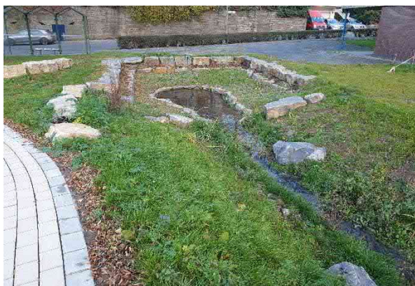
Einlauf des Bypasses am Schwimmbad (in den Buchenauer Bach)
