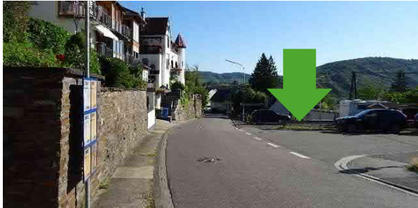
Buchholzer Straße / Peter-Josef-Kreuzberg-Straße: hier besteht die Gefahr des Wasserübertritts in die privaten Gärten
