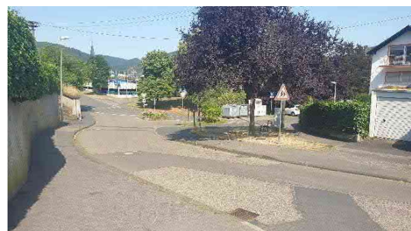
Parkstraße Richtung „Am Casino“
