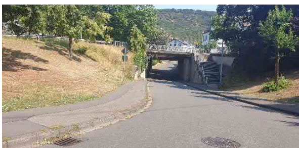
Unterführung „Am Casino“
