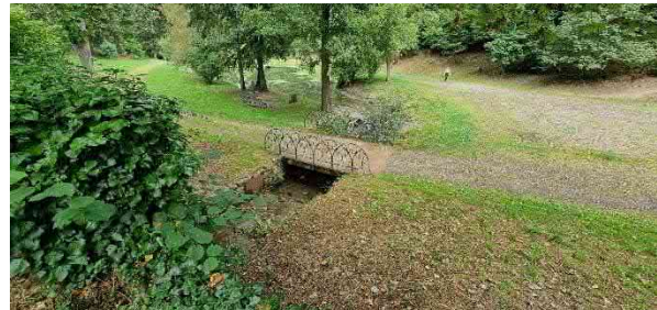
Brückenbauwerk mit Zulauf in den Teich
