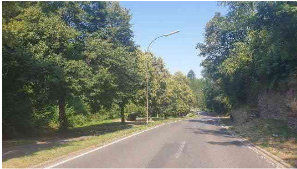
Abfluss Richtung Fußweg
