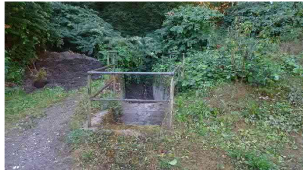
Einlaufbauwerk oberhalb der Ortslage
