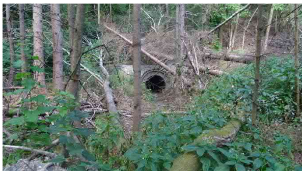
Einlaufbauwerk nördlich der BAB 61
