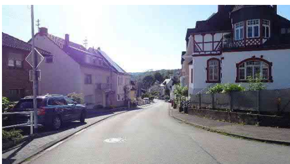
Sabelstraße / Abfluss Richtung Fraubach
