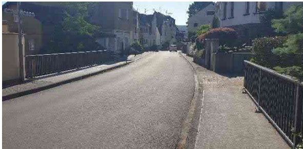
Unterführung Fraubach unter Sabelstraße: Ein Rückfluß in den Fraubach ist durch die Hochbordanlage eher nicht zu erwarten.
