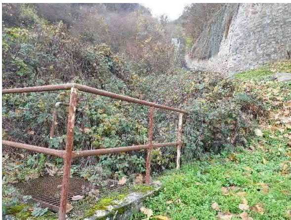
Einlaufbauwerke freischneiden und kontrollieren
