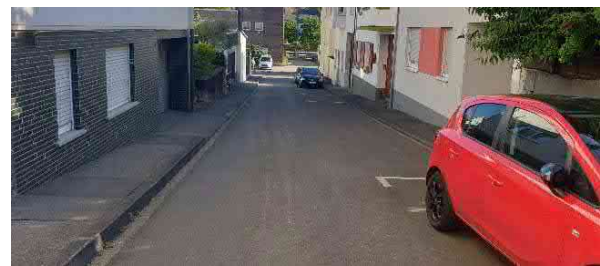
Gedeonstraße: bestehende Hochbordanlage leitet den mögl. Wasserfluß
