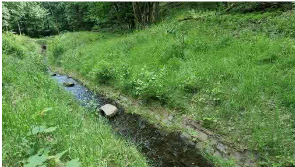
Teilw. gestickte Bachsohle nach Auslaufbauwerk im Oberlauf
