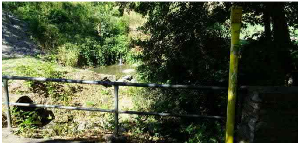
Auslaufbauwerk des Bruder-Michels-Bachs vor Marienberger Park
