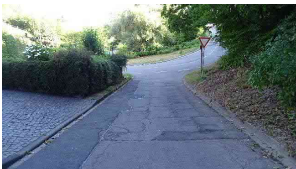
Straßeneinmündung in Buchholzer Straße: Der Notüberlauf erfolgt über den Straßenraum.
