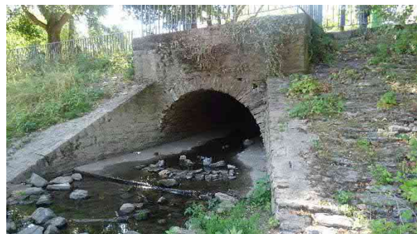
Auslaufbauwerk und Mündung in den Rhein
