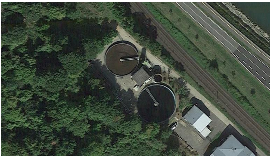
Abb. 2: Luftbild Kläranlage Bad Salzig
