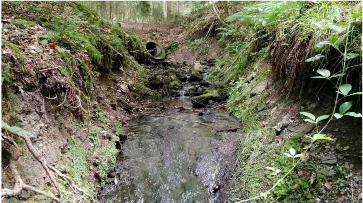
Abb. 30: Blick auf die Austrittsstelle der Industriegebietsentwässerung
