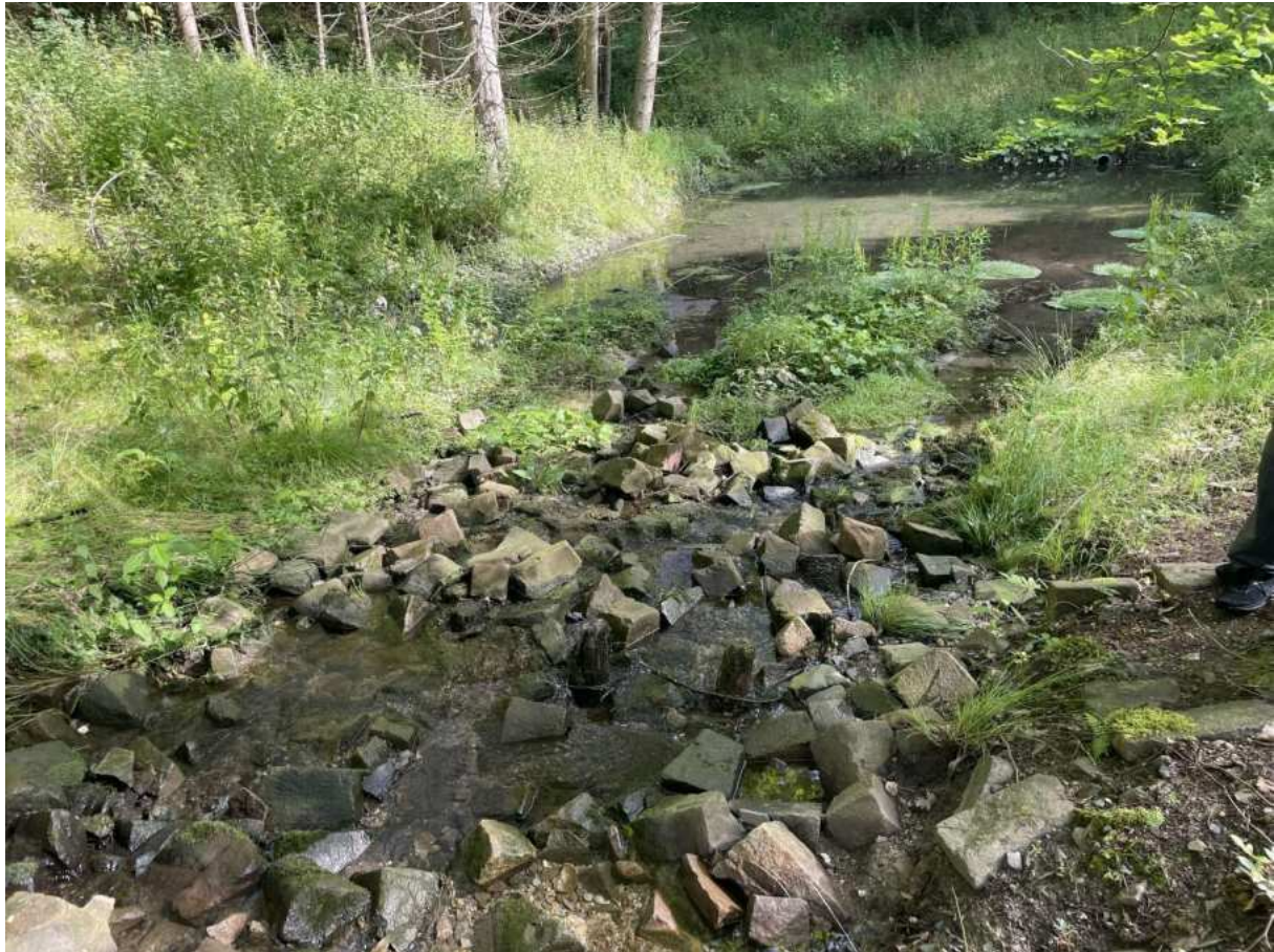
Abb. 24: Blick Richtung Norden auf das Regenrückhaltebecken
