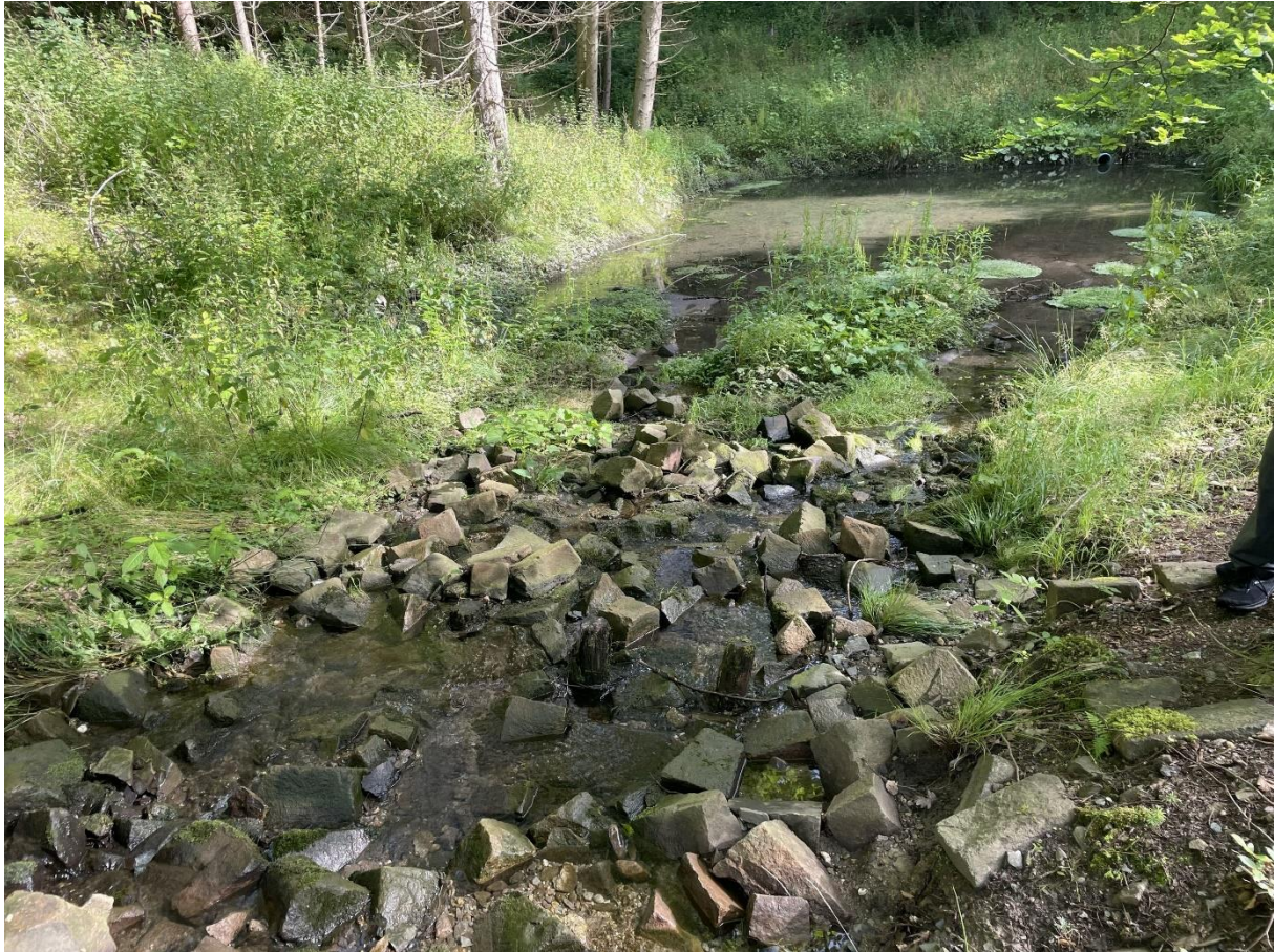
Abb. 16: Blick Richtung Norden auf das Regenrückhaltebecken
