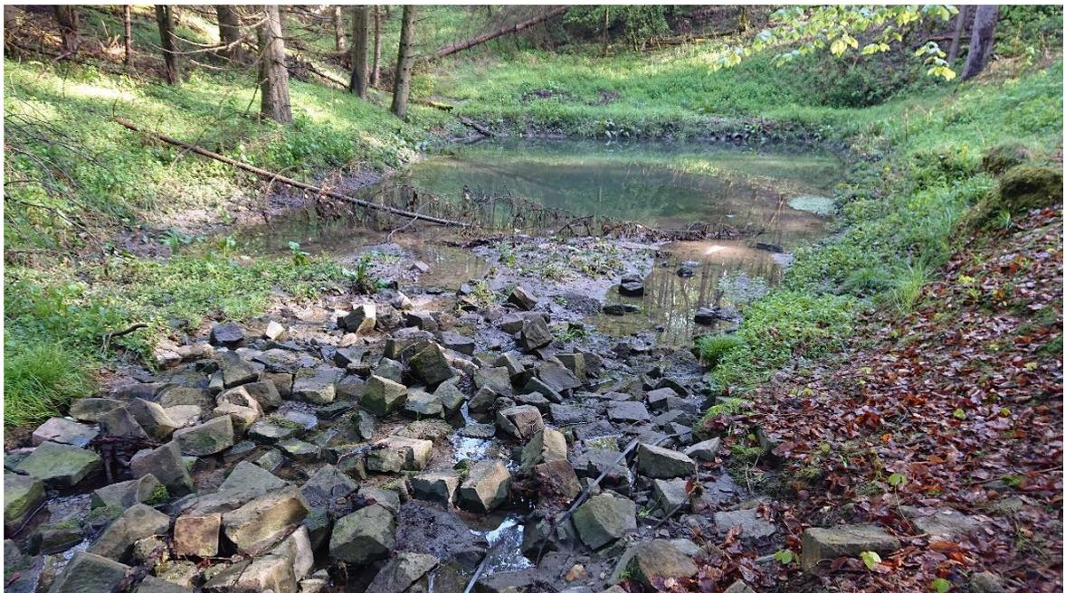
Abb. 5: Blick auf das Auffangbecken, welches bei Erreichen eines bestimmten Pegelstands das überschüssige Wasser über ein Rohrsystem unter der Autobahn ableitet.
