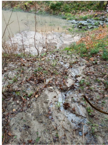
Foto 5 + 6 Zulauf / Erosionsrinne zum RRB aus NW Richtung (Industriegebiet).
